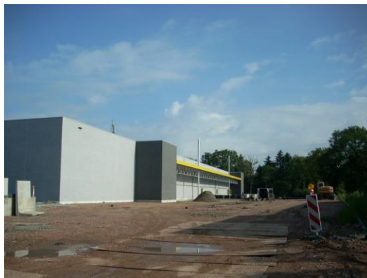
Recente KMO in aanbouw
